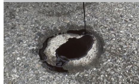
Application de BITUME LIQUIDE sur les fissures d'usures.
