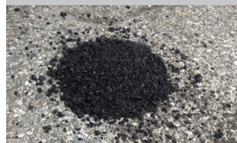
Application de gravillons sur l'émulsion.
